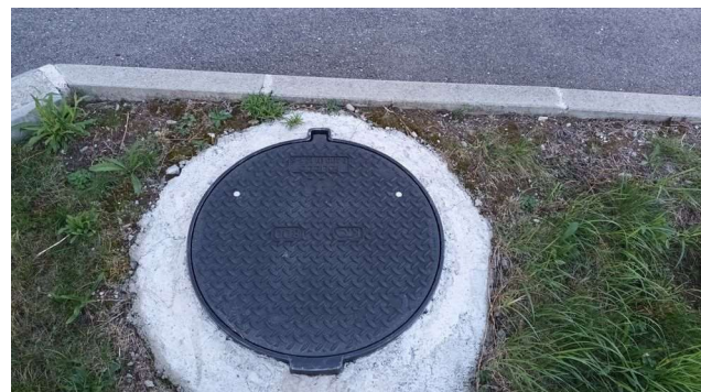
Illustration 5.3: Vue externe d'un des puits de réinjection du MINATEC BHT2 : prévu d'être réutilisé en réinjection en réseau
